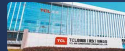
Завод в Ухане (2022)
