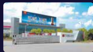
Завод в Ухане
