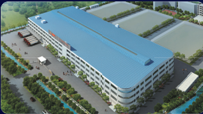
2-й завод в Чжуншане
