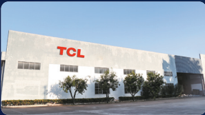
Завод по производству инверторных контроллеров
