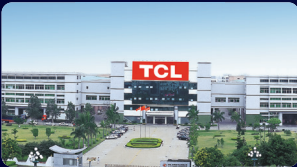
1-й завод в Чжуншане
